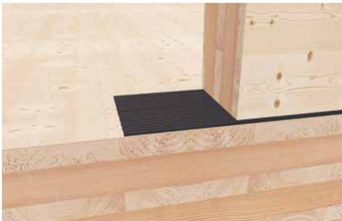
Mass-X<sup>®</sup> Entkopplungsprofil zur Materialtrennung und Schallsisolierung
