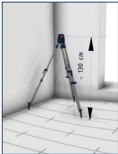
**1.2)** Positionierung des Lasers am tiefsten Punkt des Terrassengeländes
